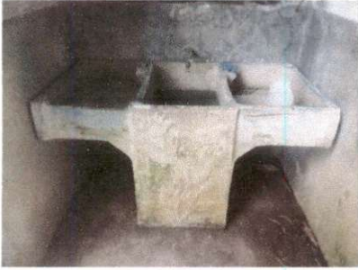
Foto7: Sustitucion de pila de cemento de dos lavaderos
