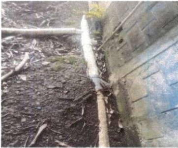
Foto 9: Susitucion de tubería PVC línea principal aguas negras
