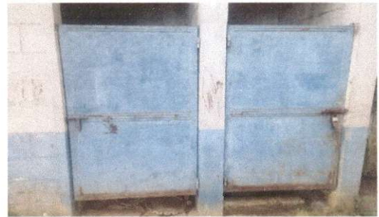
Foto 4: mantenimiento a estructura de puertas de metal
