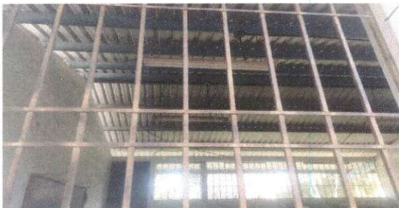
Foto 5: mantenimiento a balcones de metal
