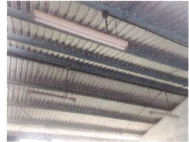
Foto 10: Sustitución de ducto electrico mas accesorios
