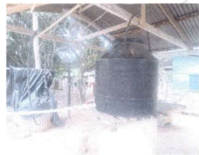
Foto 6: Sustitucion de deposito de agua de 1100 litros
