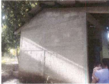
Foto1: Pintura en muros exteriores e interiores
