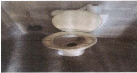
Foto 3: Sustitución de inodoros
