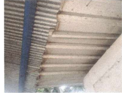
Foto 2: sustitución de lamina por lamina troquelada de aluzinc calibre 26
