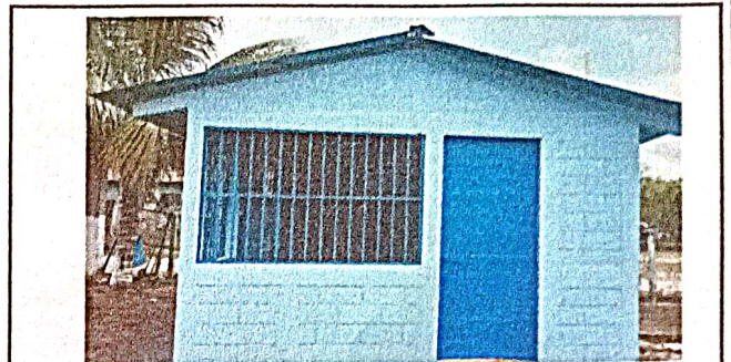
Foto 8: Fabricación e instalación de puerta de metal en módulos.
