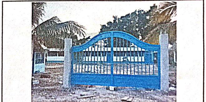
Foto 10: Sustitución de porton de metal.
