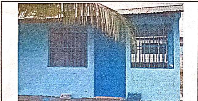
Foto 9: Fabricación e instalación de puerta de metal en módulos.
