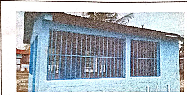
Foto7: Fabncación e instalación de balcones de metal.
