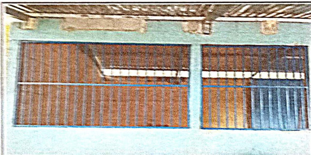
Foto 5: Fabricación e instalación de balcones de metal.
