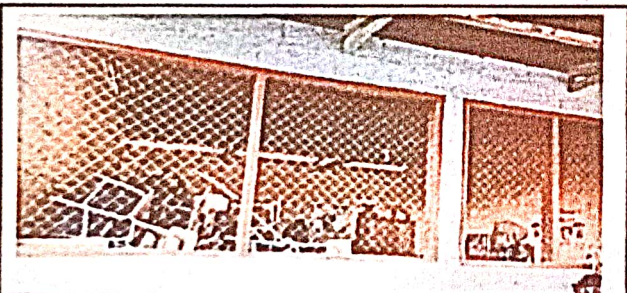
Foto 5: Fabricación e instalación de balcones de metal.
