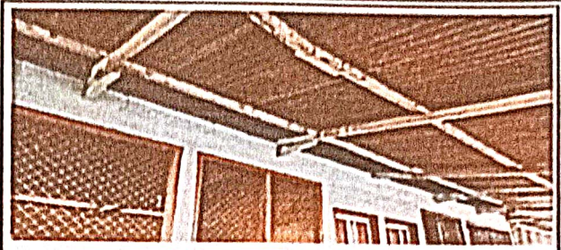
Foto 2: Sustitución de estructura de madera por metal.
