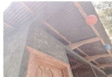
Foto 4: Sustitución de elementos de fijacion
