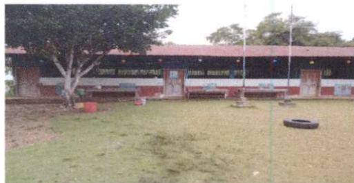
Foto 5: Sustitución de puerta aulas
