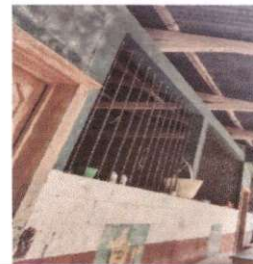
Foto 6: Mantenimiento a balcones de metal
