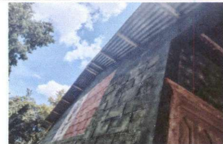
Foto 3: Sustitución de capote de lámina para lámina troquelada
