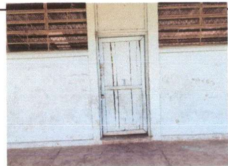
Foto 6: Sustitucion de puerta (aula 2)
