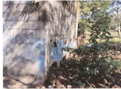
Foto 8: Pintura en muros exteriores e interiores (baños)
