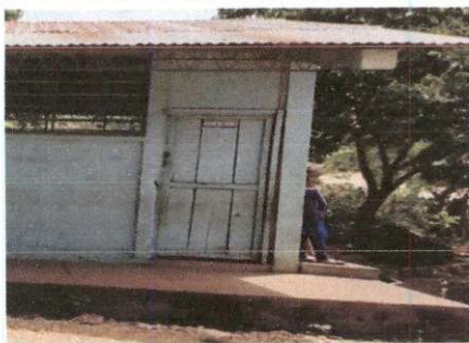
Foto 5: Sustitución de puerta (aula 1)
