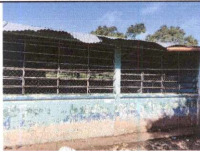
Foto 9: Susticion de Balcones de metal (aula 1)
