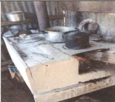
Foto 5: sustitucion de estufa rural incluye chimenea y plancha de metal
