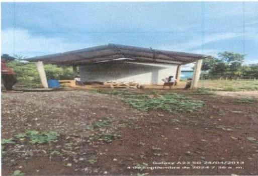
Foto 3: Sustitucion de lamina, por lamina troquelada de aluzinc calibre 26
