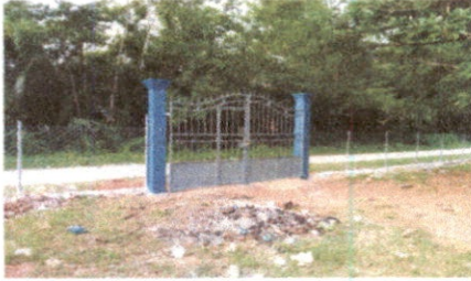
Foto 1: Sustrucción de portón de metal
