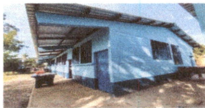
Foto 5: Pintura en muros exteriores
