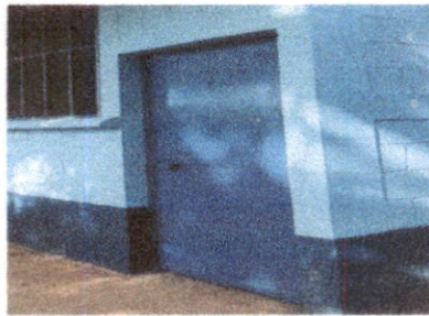
Foto 3: Sustrucción de chapa
