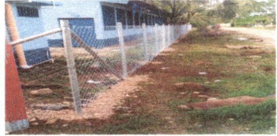
Foto 2: Reparación de tubo hg y malla galvanizada
