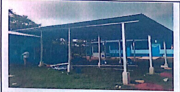
**SUTITUCIÓN DE LAMINA, POR LAMINA TROQUELADA ALUZINC CALIBRE 26**
