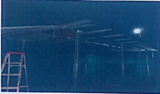
SUTITUCIÓN DE LAMINA, POR LAMINA TROQUELADA ALUZINC CALIBRE 26
