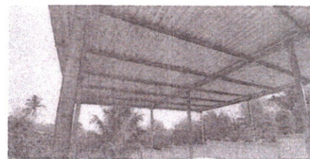
Foto 6: estructura de soporte de metal con cubierta de lamina troquelada
