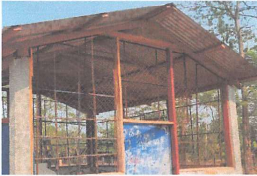
Foto 7: RENGLON 5.6 Sustitución de balcones de metal.
