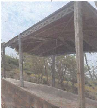
Foto 3: RENGLON 2.3 Sustitución de estructura de soporte de metal, por metal.
