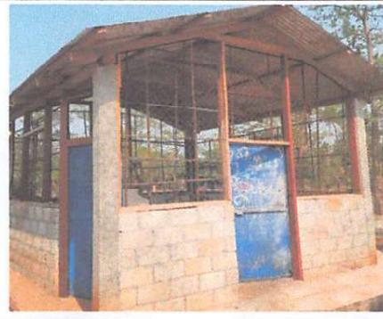
Foto 4: RENGLÓN 4.4 Sustitución de puertas.
