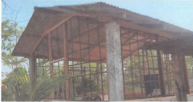
Foto1: RENGLON 1.1 Sustitución de lámina troquelada aluzinc calibre 26
