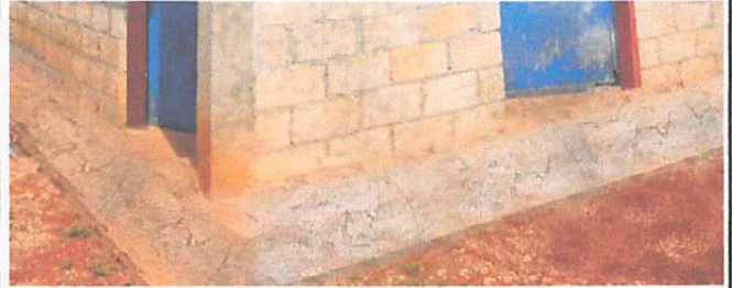
Foto 8: RENGLON 8.2 Reparación de banqueta de concreto.
