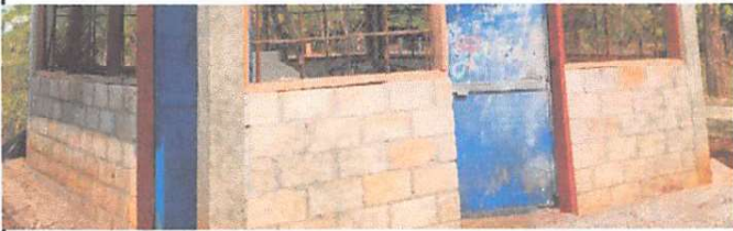
Foto 9: RENGLON 21.1 Repello en muro
