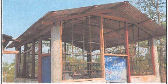
Foto 2: RENGLON 2.2 Sustitución de soporte de madera, por metal
