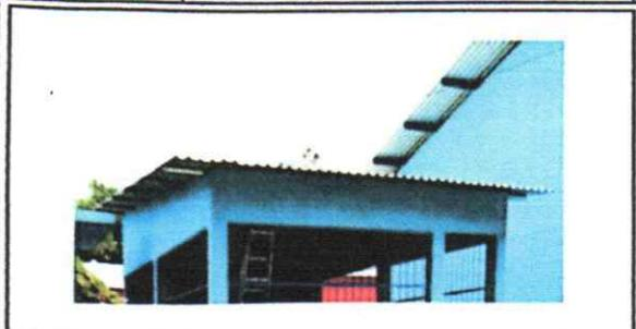
Foto 1: Sustrucción de lamina, por lamina troquelada aluzinc calibre 26 0.38 mm en cocina
