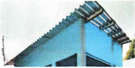
Foto 1: Sustitución de lamina, por lamina troquelada aluzinc calibre 26 0.38 mm en cocina
