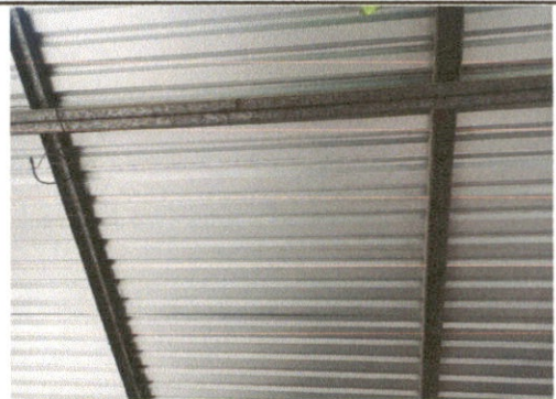
Foto 6: 2.1 Reparación en muro perimetral 26 mts 2 , 2.2 sustitución de estructura de soporte de madera, por metal.
