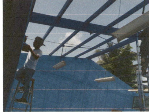
Foto 2: 2.1 Mantenimiento a estructura de soporte de metal para dirección, aulas, bodega, baños.
