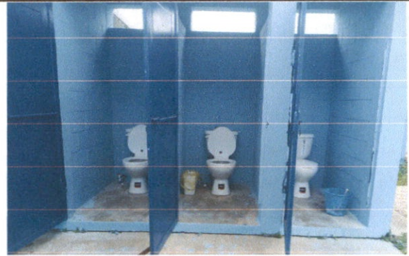
Foto 4: 10.3 Sustitucion de inodoro, 3 baños.
