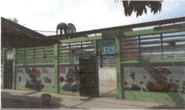
Foto1: 1.1 Sustrucción de lámina, por lámina troquelada alucin calibre 26 para dirección, aulas, bodega, baños y tribuna cívica.
