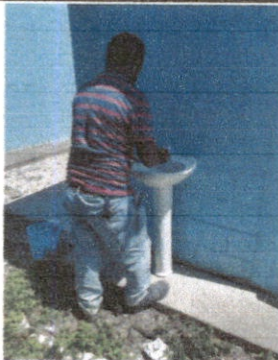
Foto 5: 10.5 Sustrucción de 3 lavamanos.
