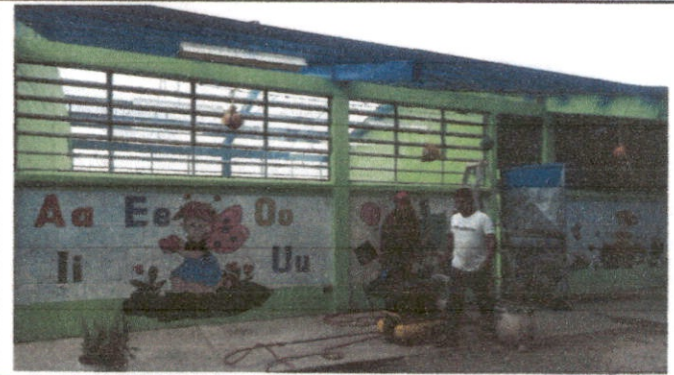
Foto 2: 2.1 Mantenimiento a estructura de soporte de metal para dirección, aulas, bodega, baños.
