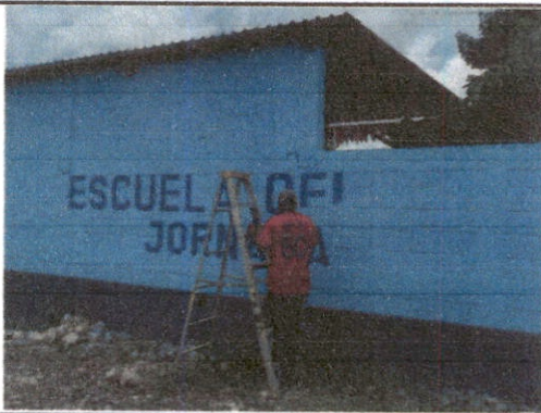
Foto 3: 9.1 Pintura en muro interior y exterior, dirección, aulas, bodega, baños y tribuna cívica.
