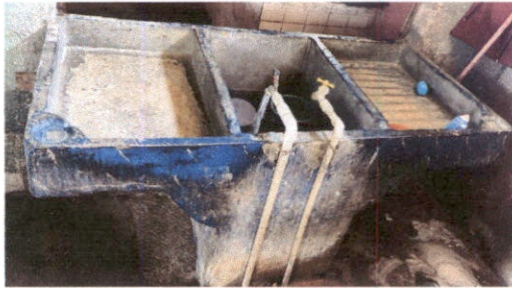
SUSTITUCIÓN DE PILA DE CONCRETO 2 LAVADEROS
