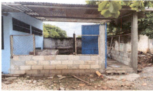
REPARACION DE MURO DE CONTENCIÓN
