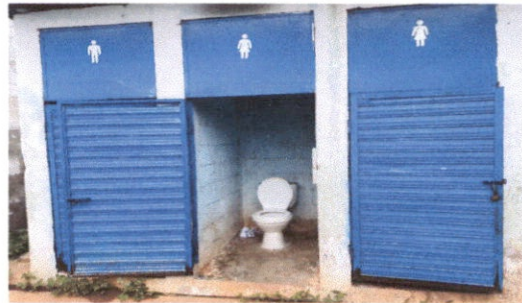
SUSTITUCION DE PUERTAS EN SERVICIO SANITARIO
