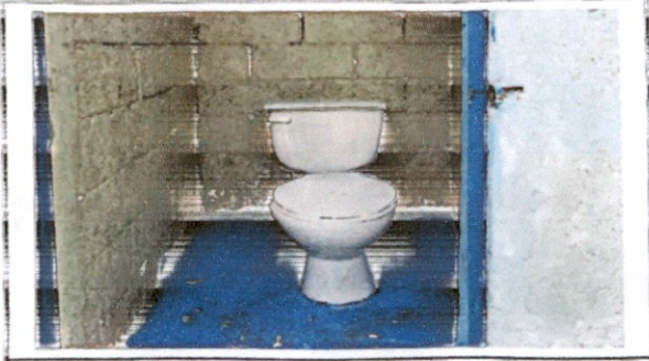
Sustitución de inodoro
