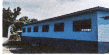
Foto 2: sustitución de lamina por lamina troquelada de aluzinc calibre 26
