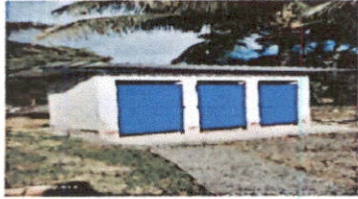
Foto 3: sustitución de puertas en servicios sanitarios
