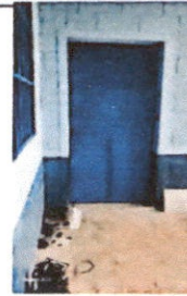
Foto 4: - Mantenimiento a estructura de puertas. - Cambio de chapas
