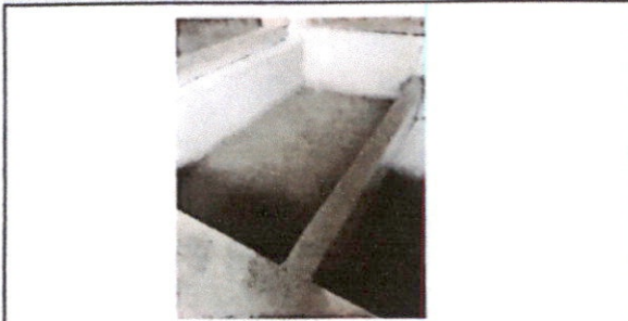
Foto 7: sustitución de pila de cemento de dos lavaderos
