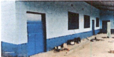
Foto 5: pintura en muros interior y exterior
