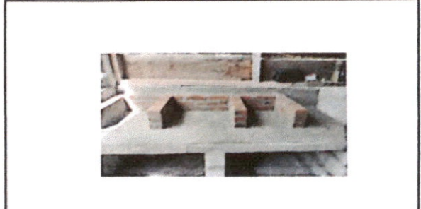
Foto 8: sustitución estufa rural
