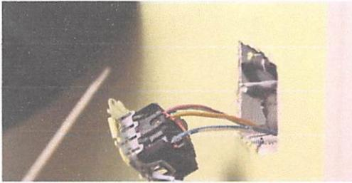
Foto 9: sustitución de tomacorrientes dobles
