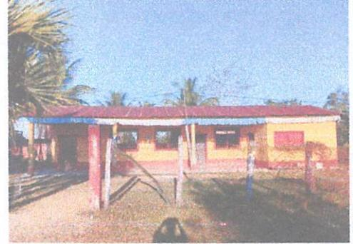
Foto 2: sustitución de lamina por lamina troquelada de aluzinc calibre 26
