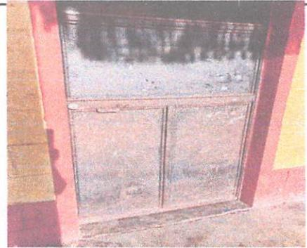
Foto 4: - Mantenimiento a estructura de puertas. - Camio de chapas
