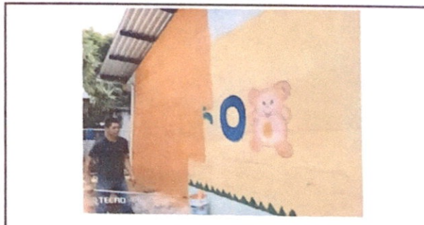
Foto 6: pintura interior en muros
