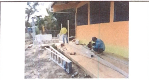
Foto 5: sustitucion de lamina
