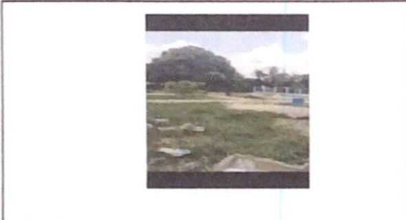
Foto 1: Reparación de planchas de concreto de patio
