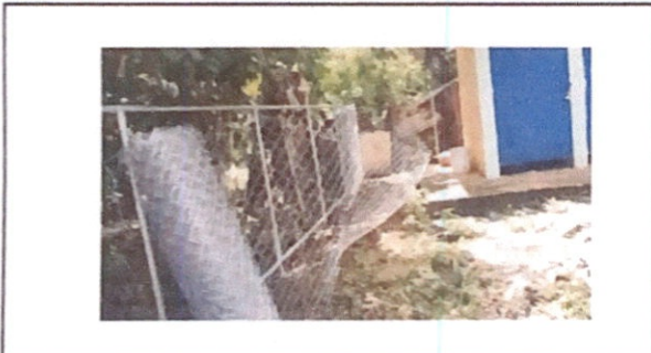
Foto 3: reparacion de tubo hg y malla galvanizada
