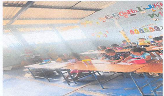
Foto 6: pintura interior en muros
