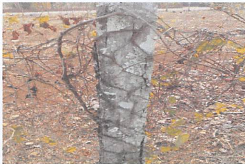
Foto 3: reparacion de tubo hg y malla galvanizada
