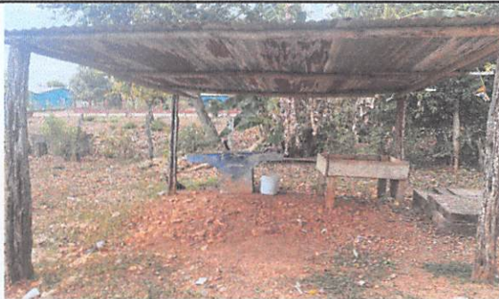
Foto 5: sustitucion de lamina
