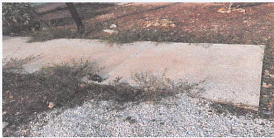
Foto 1: Reparacion de planchas de concreto de patio
