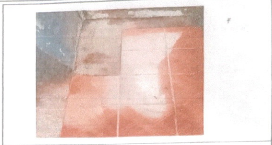
SUSTITUCIÓN DE CERAMICA
