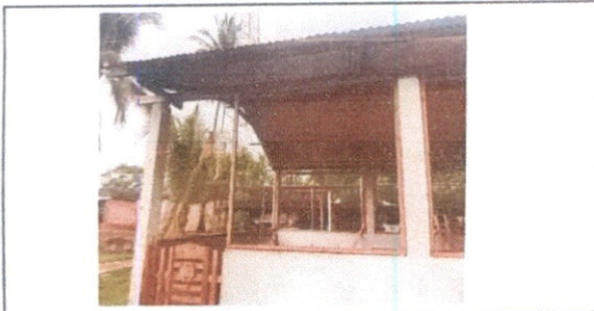
fabricacion e instalacion de puerta de metal en modulo
