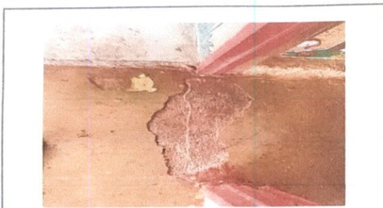
sustitucion de torta de concreto
