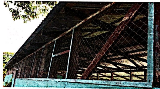
Foto 4: Reparación de Ventana en malla
