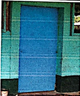
Foto 3: sustitución de puertas de metal
