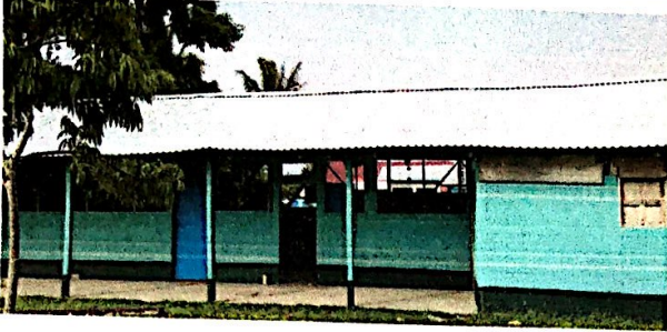
Foto1: sustitución de Lámina Troquelada aluzinc
