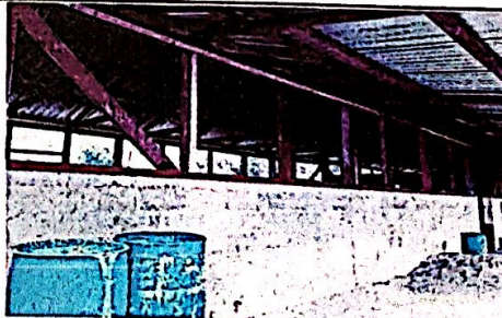
Foto 6: Sellado de Grietas y Fisuras en muros
