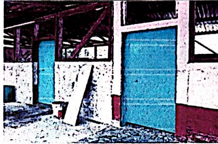
Foto 2: Sustrucción de Puertas de metal
