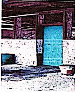
Foto 3: Sustrucción de puertas de metal
