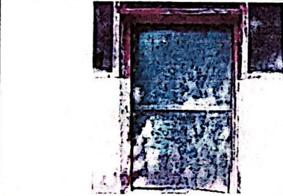
Foto 3: sustitución de puertas
