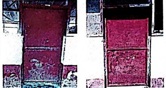
Foto 2: sustitución de puertas
