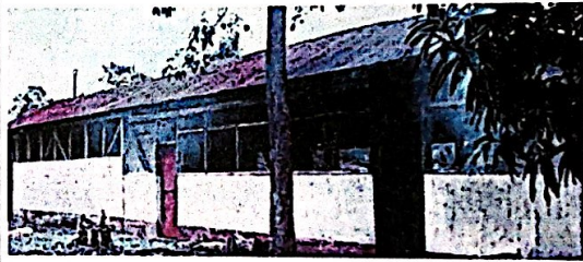
Foto 4: sustitución de maya por malla corrida
