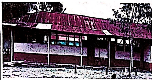
Foto 1: sustitución de lámina por lámina troquelada
