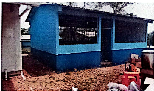
Foto 3: Pintura en muros interior y exterior
