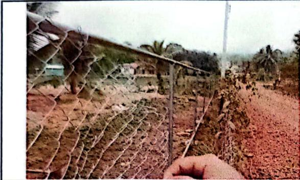
Foto1: Sustitución de madera con tubo galvanizado y maga HG
