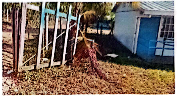
Foto 2: Sustitucion de porton de madera por porton de Metal
