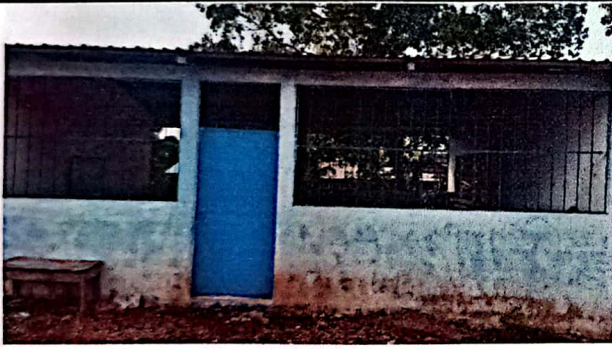
Foto 3: Pintura en muros interior y exterior
