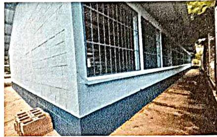
Foto 2: Sustitución de Balcones de Metal.
