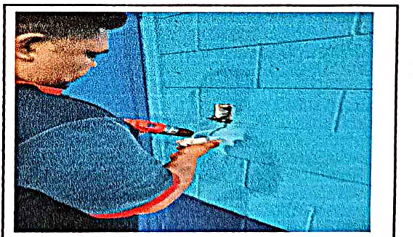
Foto 12: Reparación de cableado eléctrico e Instalación de unidades luz (incluye interruptor, tomacorriente, ducto y cable eléctrico)
