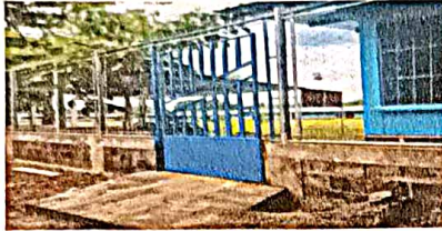
Foto 13: Mantenimiento a estructura (lijado, cambio de tubo , cepillado, sujeciones, aplicación de pintura) Puerta ingreso y salida escuela
