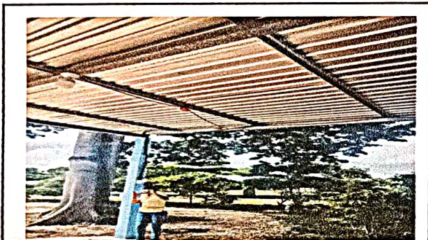
Foto 9: Sustitución de elementos de fijación
