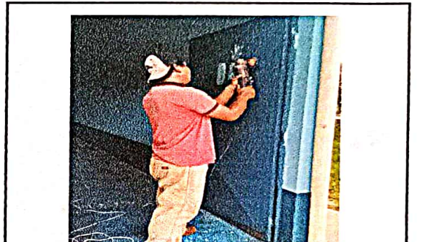
Foto 10: Mantenimiento a estructura (lijado, cambio de tubo, cepillado, sujeciones, aplicación de pintura) aulas
