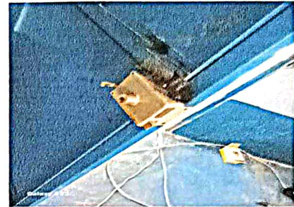
Foto 14: sustitución de chapa.
