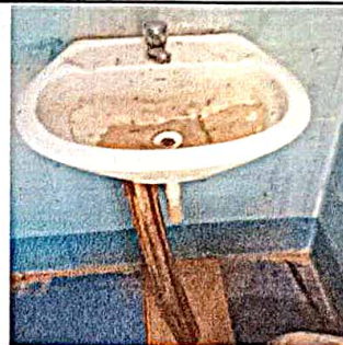
Foto 4: Sustitución de Lavamanos.
