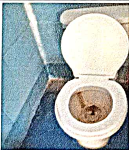
Foto 5: Sustitución de Inodoro.
