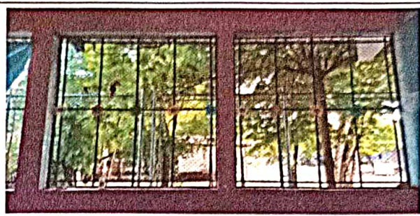
Foto 2: Sustitución de Balcones de Metal.
