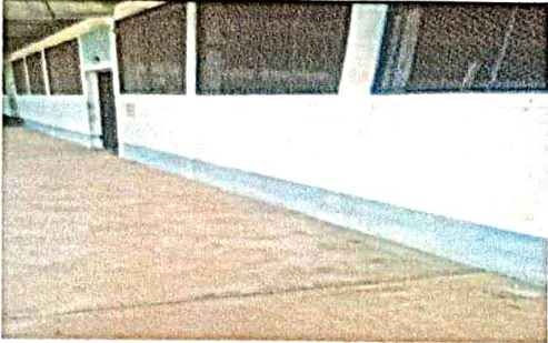
Foto1: Pintura en muros exteriores e interiores modulo aulas
