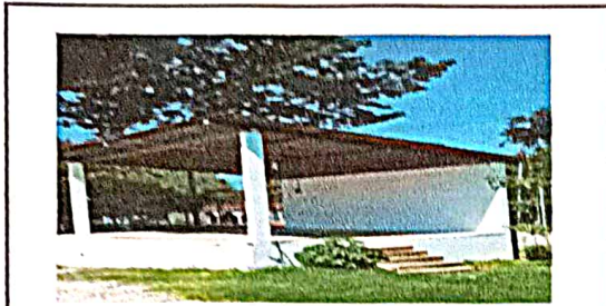
Foto7: sustitucion de lamina por lamina troquelada aluzinc calibre 26 para esenario
