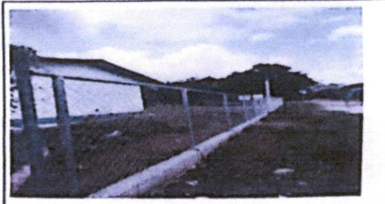
Foto 2: Reparación de tubo hg y malla galvanizada
