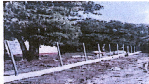
Foto 2: Reparación de tubo hg y malla galvanizada
