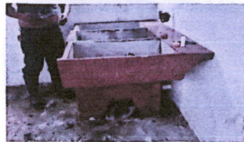
Foto 4: Sustitución de pila de cemento de dos lavadero
