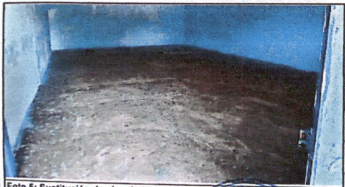
Foto 5: Sustitución de piso de torta de concreto
