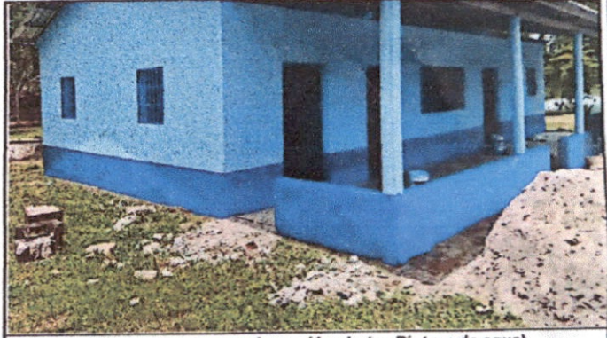
Foto 4: Pintura en muros exteriores (4 cubetas Pintura de agua)
