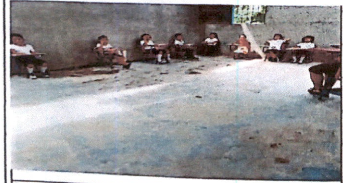
Foto 5: Sustitución de piso de torta de concreto liso
