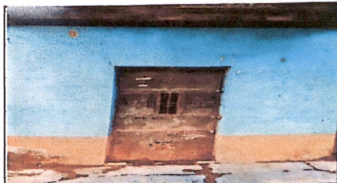
Foto 6: Sustitucion de Puerta
