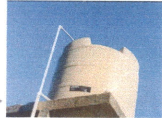
Foto 2: sustitucion de deposito de agua
