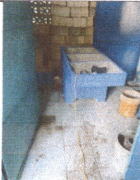
Foto 3: sustitucion de pila de concreto
