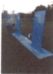
Foto 5: Mantenimiento a puertas de metal
