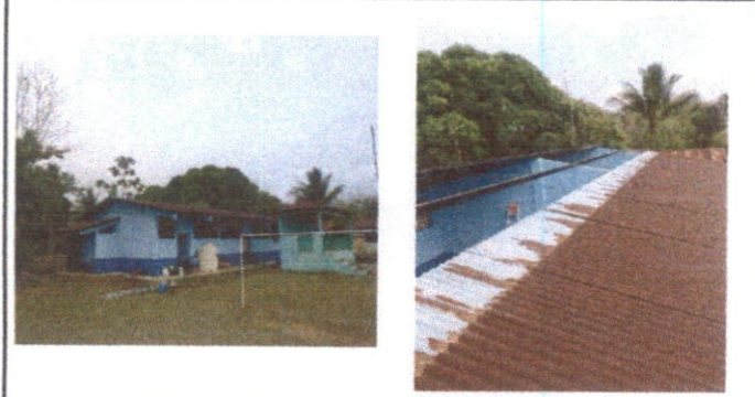
Foto1: pintura en muros interior y exterior - sustitucion de lamina troquelada
