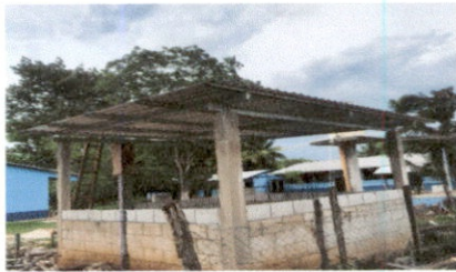
Foto1: Sustrucción de lamina, por lamina troquelada aluzinc calibre 26 0.38 mm en cocina
