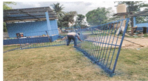
Foto 4: Sustrucción de balcones de metal
