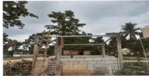
Foto 2: Sustrucción de estructura de soporte de madera por metal costanera ch 16 3x2 y Tubo Rectangular 4x2 ch16
