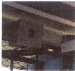
Foto 15: Sustrucción de flipones
