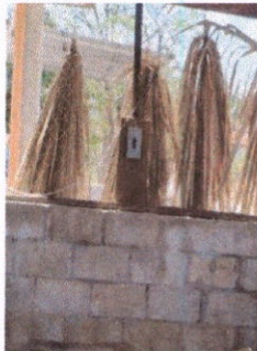
Foto 15: Sustitución de filipones
