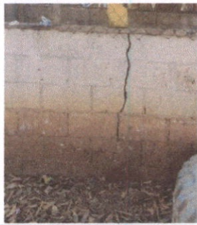
Foto 9: Sellado de grietas y fisuras en muros
