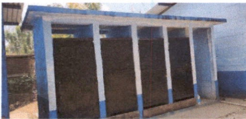
Foto 11: Mantenimiento a estructura de puerta (lijado, cambio de tubo, cepillado, sujeciones, aplicación de pintura)
