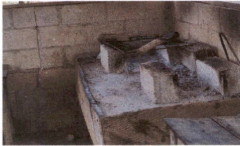
Foto 7: Instalación de azulejo en estufa rural
