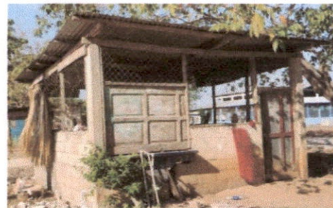
Foto 12: Pintura en muros exteriores e interiores
