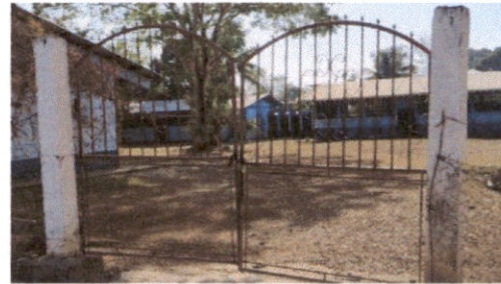
Foto 10: Sustitución de portón de metal
