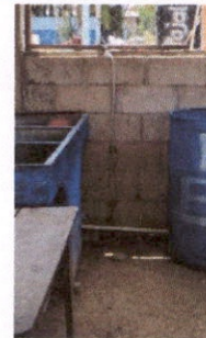
Foto 16: Sustitución de tomacorriente doble
