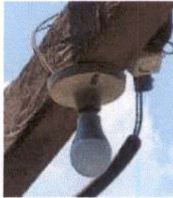
Foto 13: Sustitución de focos ahorradores
