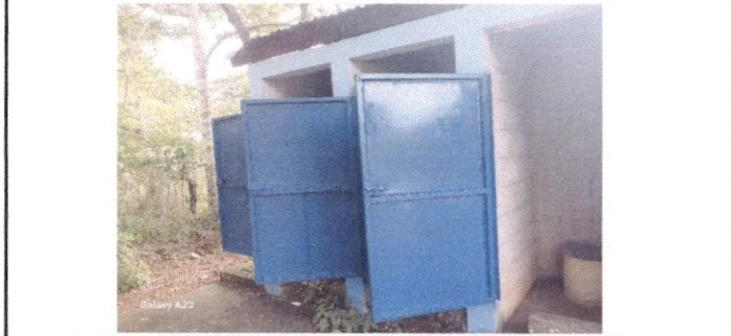
Foto 6: Mantenimiento a estructura (lijado, cambio de tubo , cepillado, sujeciones, aplicación de pintura) a puertas servicios sanitarios
