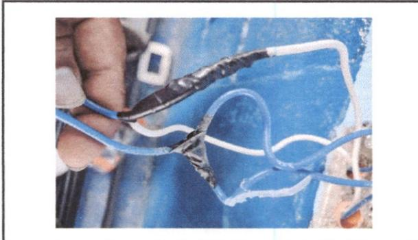
Foto 9: Reparación de cableado electrico
