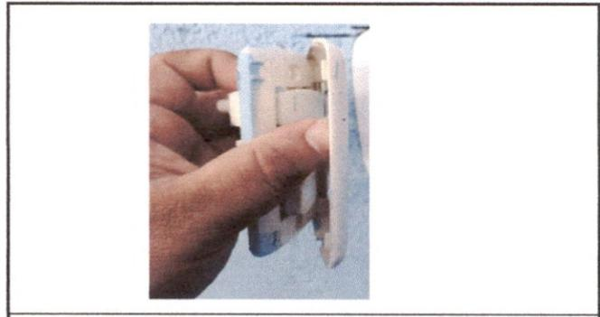
Foto 12: Sustitución interruptores simples
