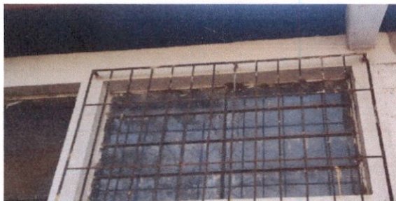
Foto 5: Sustitución de balcones de metal
