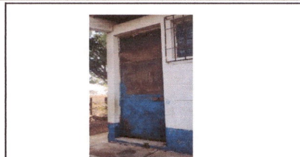
Foto 8: Mantenimiento a estructura de puertas de metal
