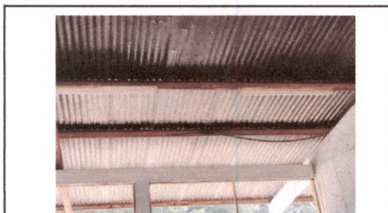
Foto 9: Reparación de cableado eléctrico
