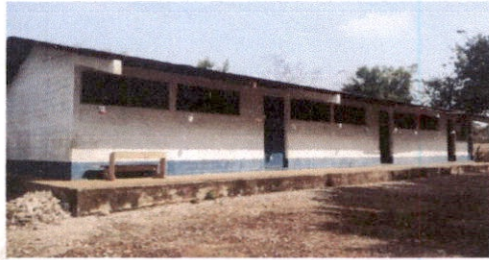
Foto 3: Sustitución de capote de lámina para lámina troquelada
