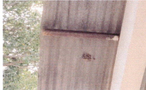
Foto 2: Mantenimiento a estructura de soporte de metal
