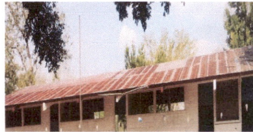
Foto 4: Sustitución de elementos de fijacion
