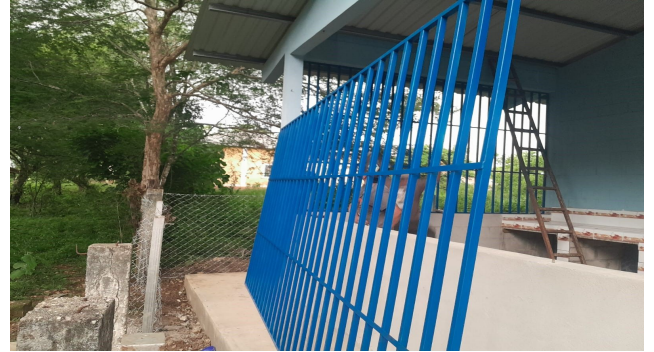
2. SUSTITUCIÓN DE BALCONES
