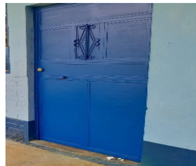
6. SUSTITUCIÓN DE CHAPA
