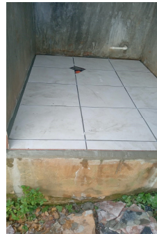
4. SUSTITUCIÓN DE INODORO
