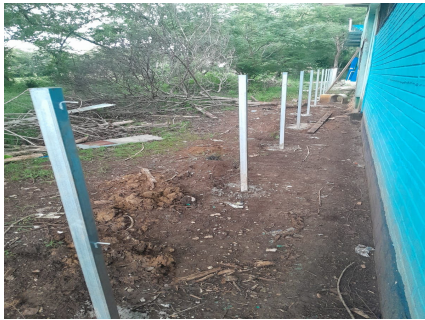
3. REPARACION DE TUBO HG Y MALLA GALVANIZADA
