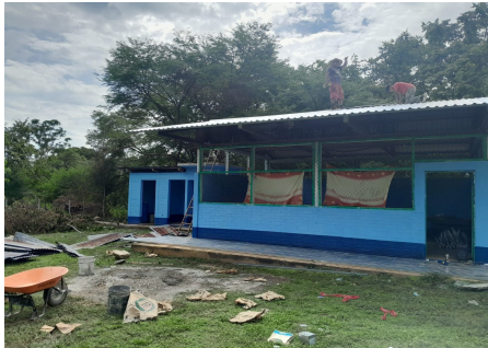
1. SUTITUCIÓN DE LAMINA, POR LAMINA TROQUELADA ALUZINC CALIBRE 26
