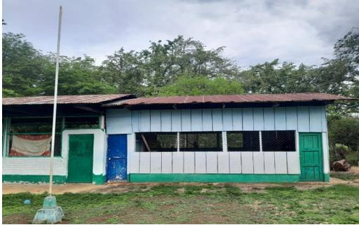
**1. SUTITUCIÓN DE LAMINA, POR LAMINA TROQUELADA ALUZINC CALIBRE 26**
