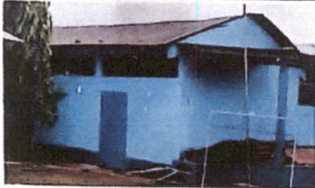
SUSTITUCIÓN DE PUERTA
