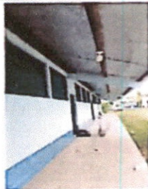
MANTENIMIENTO EN BALCON DE METAL
