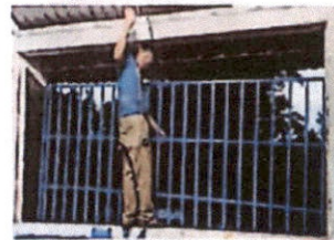
SUSTITUCIÓN DE BALCÓN
