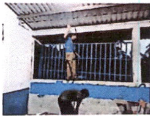
MANTENIMIENTO EN BALCON DE METAL
