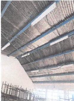
SUSTITUCIÓN DE LAMINA POR LAMINA TROQUELADA ALUZINC CALIBRE 26
