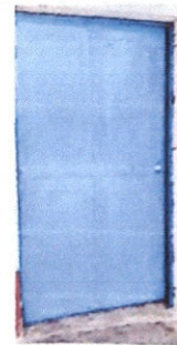
Foto 4: Puertas de las aulas
