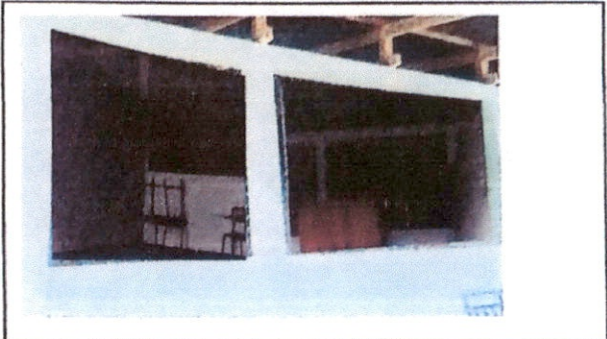
Foto 2: Ventana para balcones de las aulas a remozar
