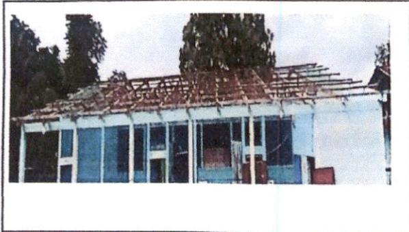
Foto 1: Techo de las aulas a Remozar
