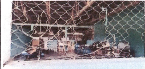
Foto 2: Balcones de las 3 aulas
