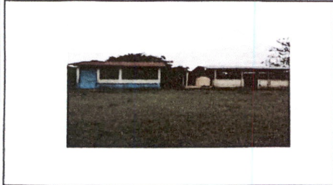
Foto1: Cubierta de lámina
