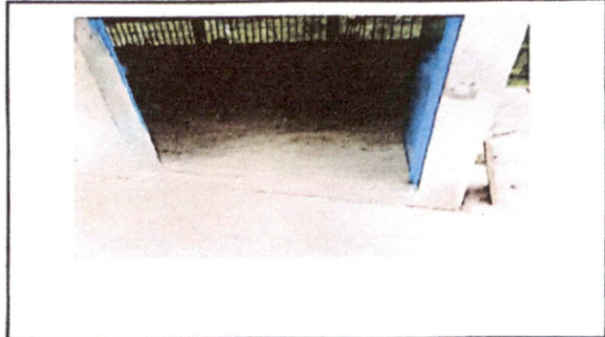
Foto 2: Mantenimiento de piso de Granito (pulido)
