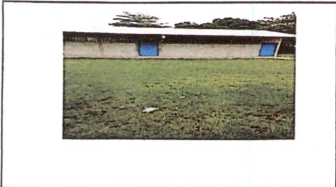
Foto 3: Pintura en Muros Exteriores
